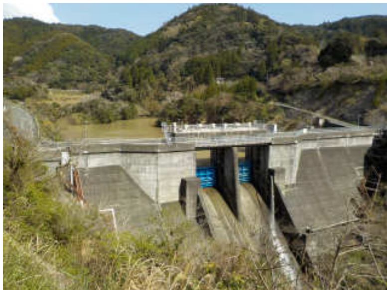
水道水源の小向ダム
