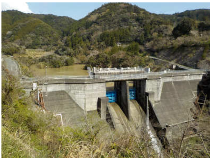
水道水源の小向ダム
