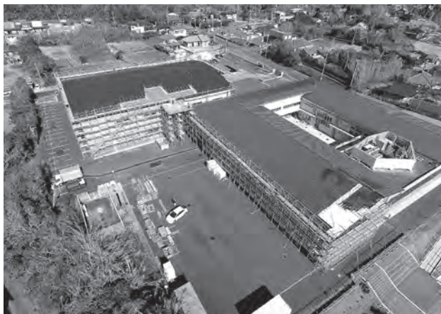
施設修復の様子
