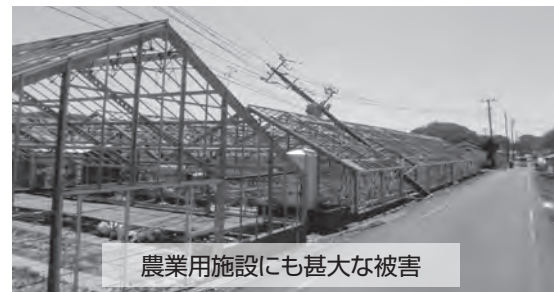
台風15号の強風で倒れた電柱
