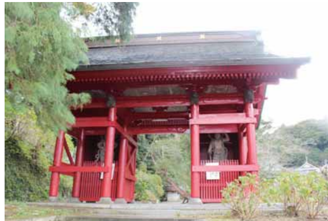
修理工事後の仁王門
