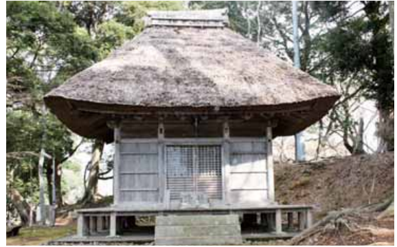
修理前の石堂寺薬師堂
