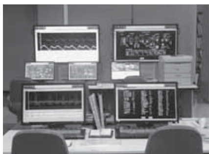
浄水場中央監視システム(小向浄水場)
