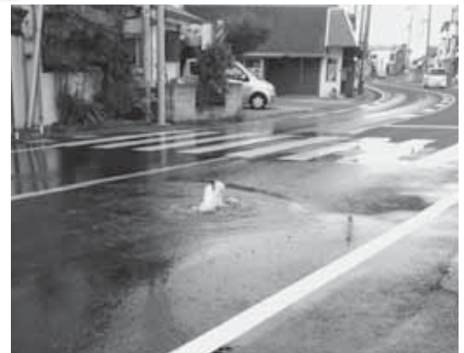
配水管の漏水(和田地区仁我浦)
