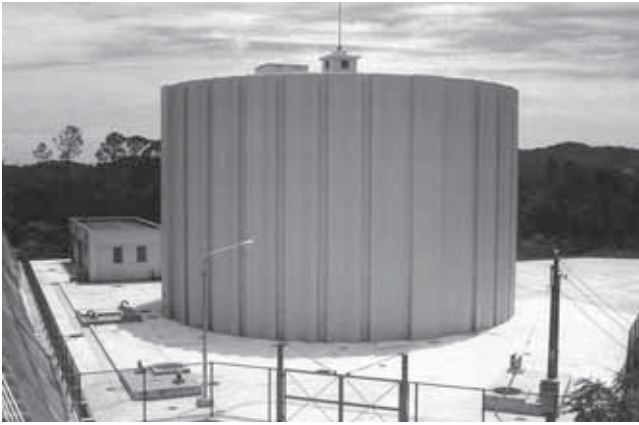
千倉第二配水池(千倉地区南朝夷)
