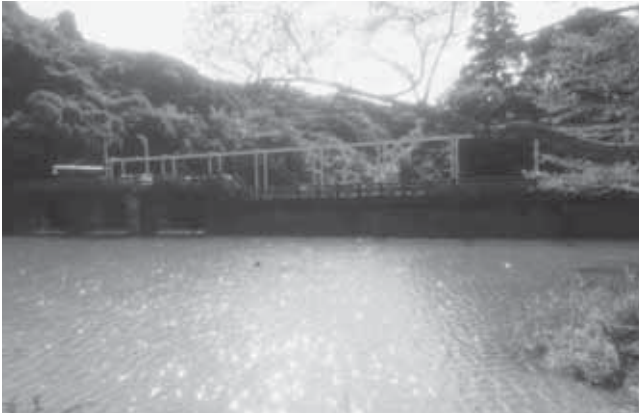
白浜ダム(白浜地区白浜)
