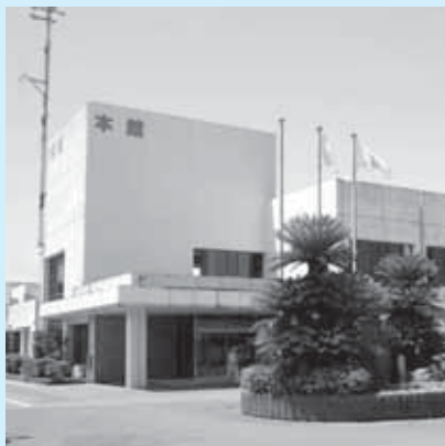
現在、市民生活部や議場がある南房総市役所本館
