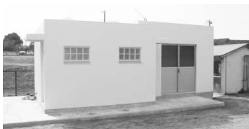
運動広場内の新築したトイレ
