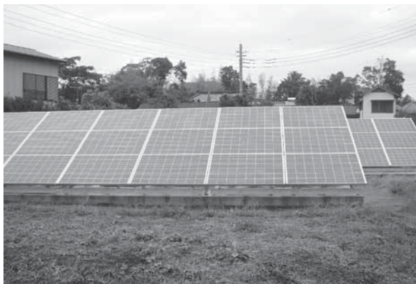
新規に設置された太陽光パネル
