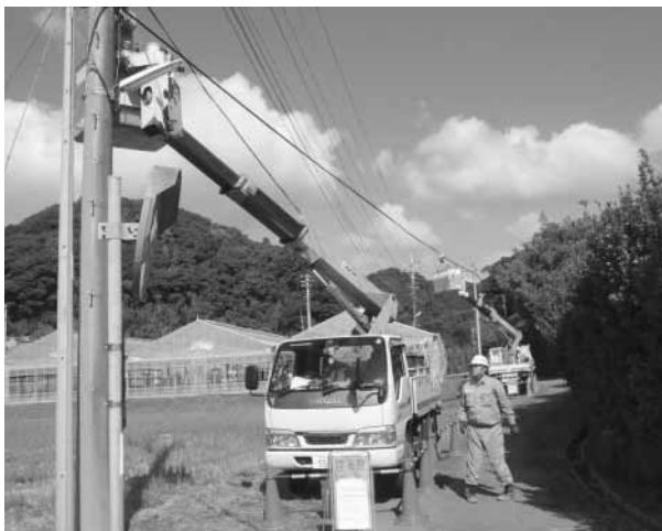
光ファイバー敷設工事の様子
