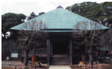
国指定重要文化財 石堂寺本堂
