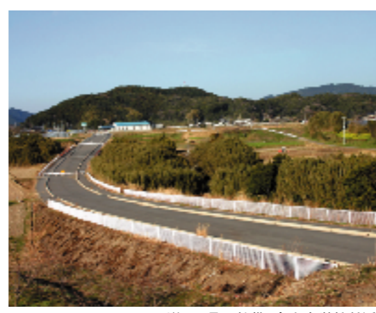
国道410号の整備 丸山中学校付近
