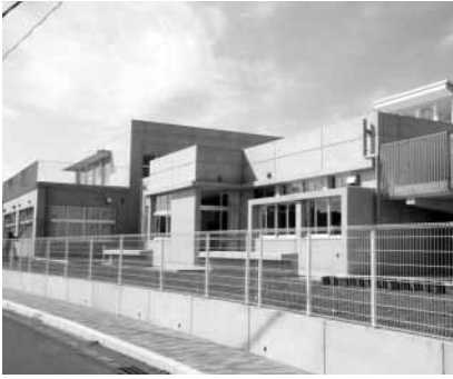
完成した健田小学校校舎
