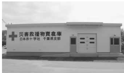
建設された災害救援物資備蓄倉庫
