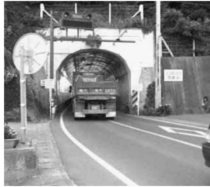
国道127号坂ノ下トンネル
